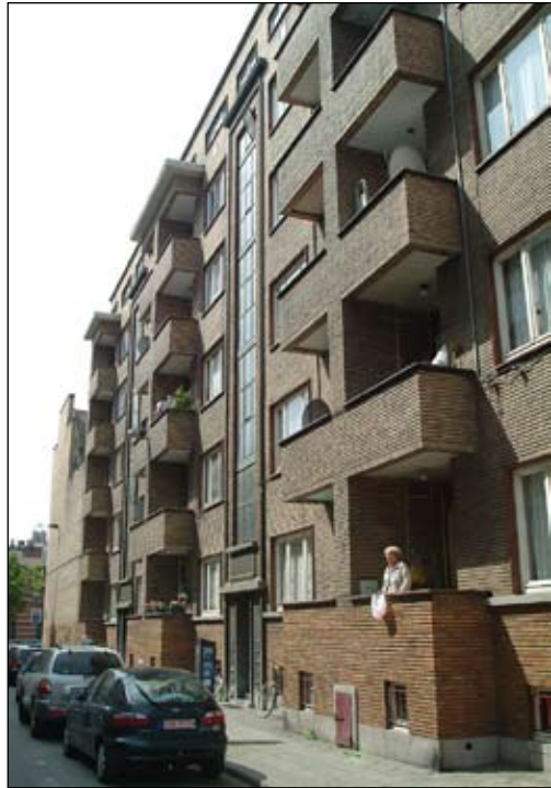
Rechtsboven: façade van het bouwblok in de Van Craesbeeckstraat met gedubbelde balkons en ingewerkt vuilschuifstelsysteem.
