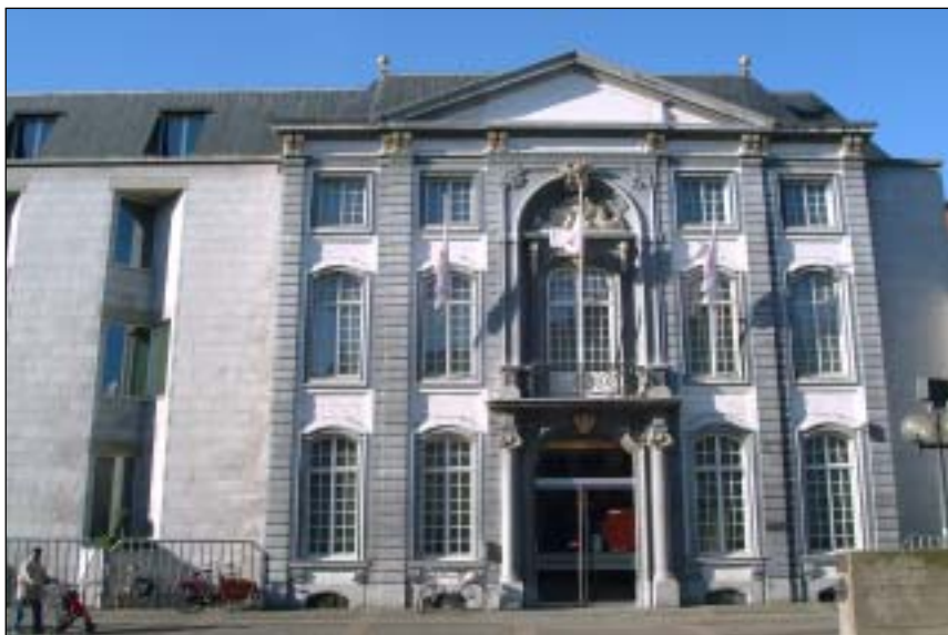
Fortis-gebouw op de Wapper, met geïntegreerde voorgevel van het hôtel de Fraula van de Keizerstraat in Antwerpen, gesloopt in 1963. (Foto Wim Strecker, 2007-02-03)
