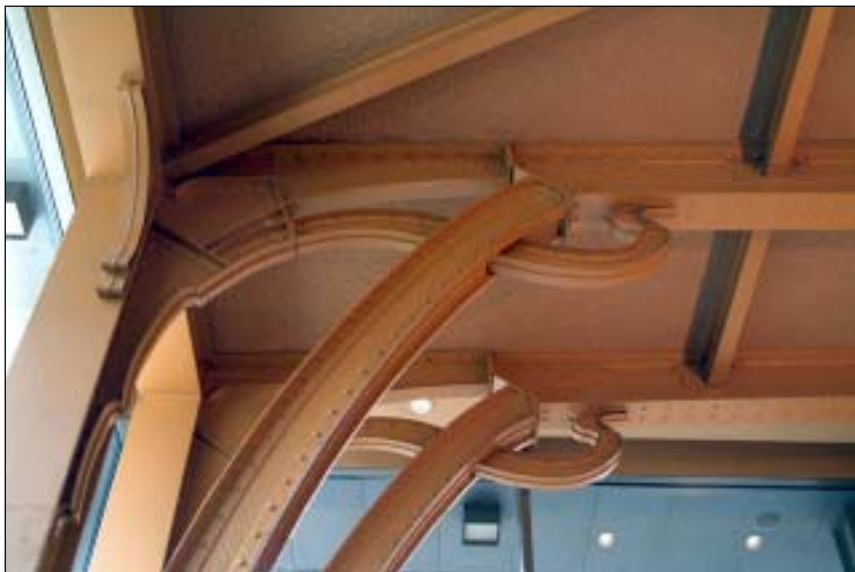
Interieurdetail van het 'Grand café Horta', Maria Pijpelincxstraat. Herbruikte spanten uit het Volkshuis van Horta in Brussel, gesloopt in 1965. (Foto Wim Strecker, 2006-12-23)
